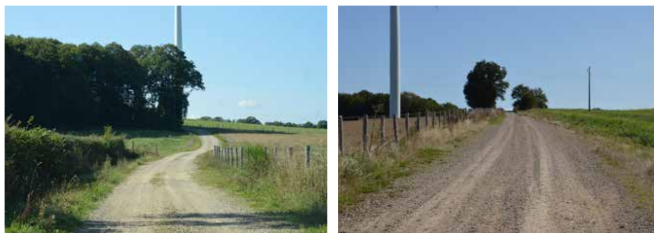
Exemples de pistes d'accès, parc éolien de la Souterraine
